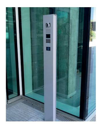
L'intero sistema interfonico è stato integrato con sistema BMS Siveillance Siemens per gestione e diagnostica.
